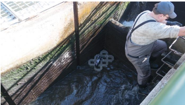
13 pav. Imtuvo instaliavimas žuivitakyje. (Agneškos Godlijevskos nuotrauka, 2014 m.)
