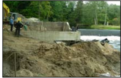
10 pav. Žuvų pralaidos statybos darbų pradžia Šventosios (Baltijos jūra) upėje (rangovas - UAB „Šilutės polderiai“)
