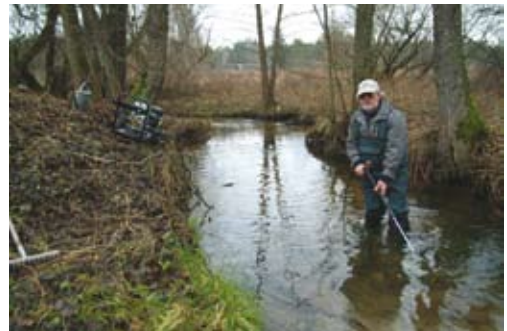
2 pav. Upės vagos gilinimas naudojant aukšto slėgio vandens aparatą (Foto H. Sakalausko)
