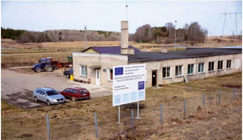
Pastatas po rekonstrukcijos
