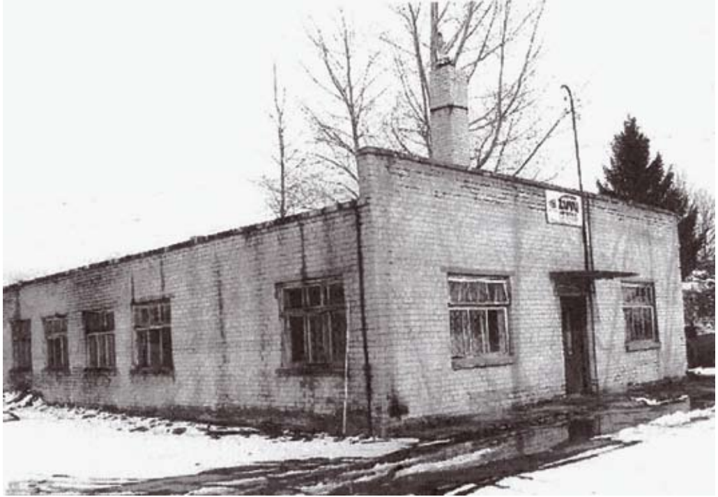
Pastatas prieš rekonstrukciją
