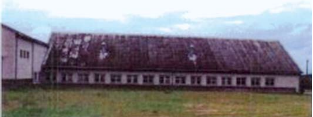
Pastatas prieš rekonstrukciją
