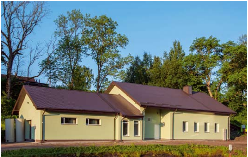
Pastatas po rekonstrukcijos
