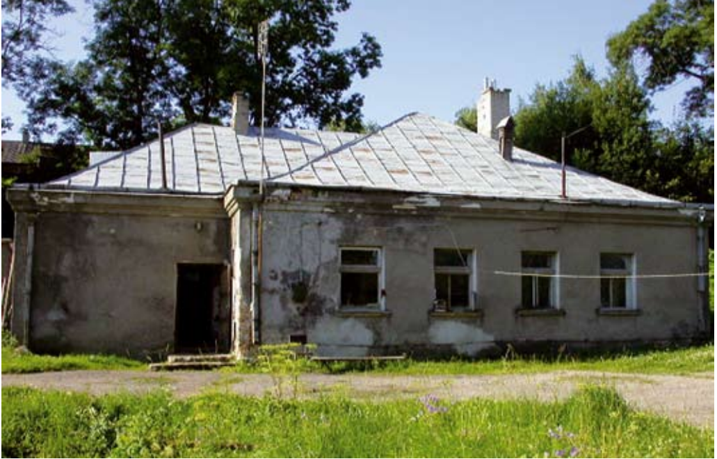
Pastatas prieš rekonstrukciją
