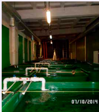
Rusnės poskyrio žuvų veisimo cechas po paprastojo remonto darbų
